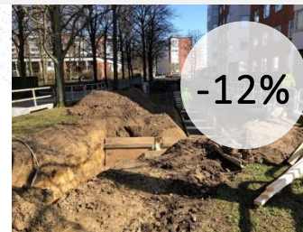
Kraftringen, fjärrvärmeledning, Lund
