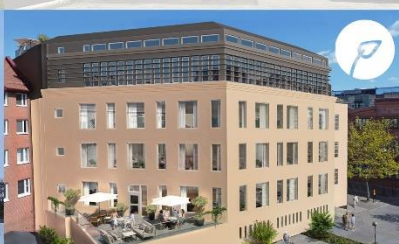
Pågående: Gasverket 6, Lund Nybyggnad av kontorslokaler
